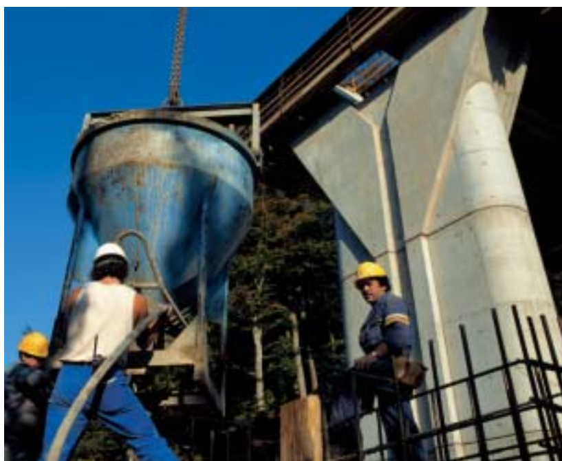
L'Inspection du travail et des mines contrôle la sécurité ainsi que le respect des réglementations sur les chantiers
